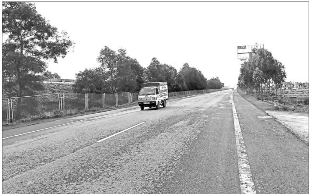
Xây dựng đường mới cùng lúc với làm đường gom sẽ giảm được nhiều khó khăn về sau. Trong ảnh: Đường gom cao tốc Hà Nội - Hải Phòng được xây dựng đồng bộ cùng với đường chính, đã phát huy hiệu quả
